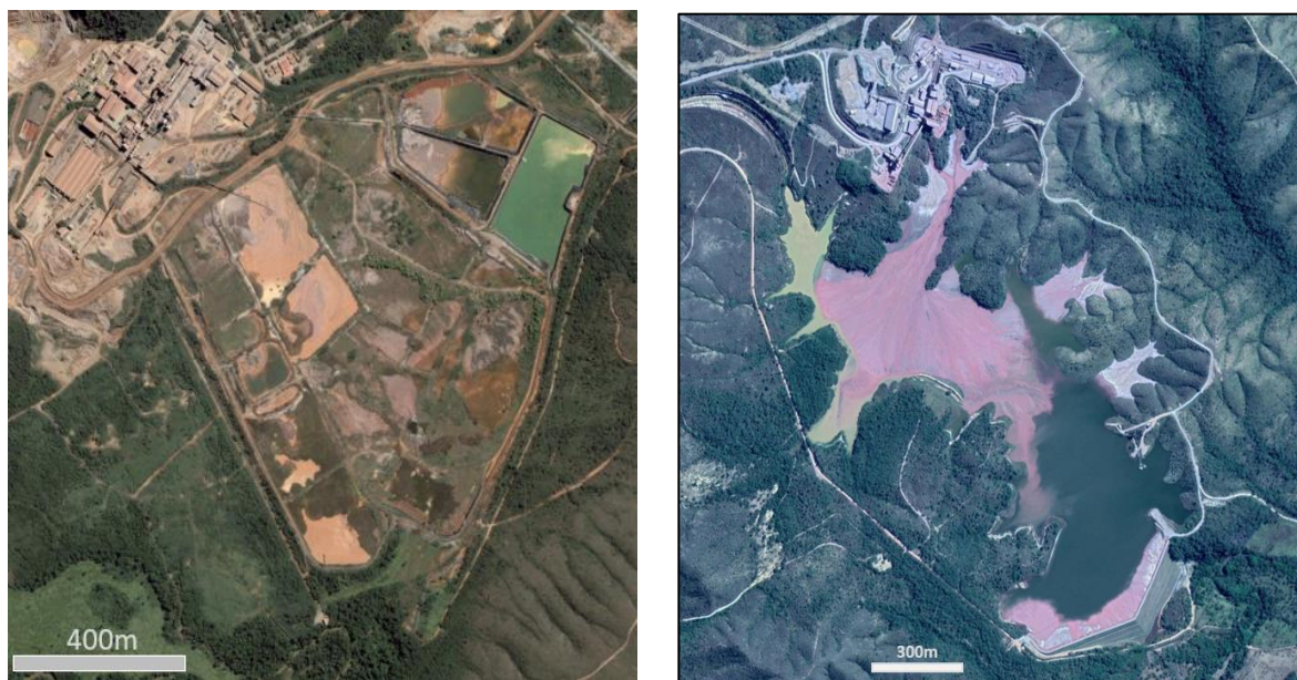
Figura 2: A – Imagem de satélite da Barragem Antiga no fim de vida útil; B – Imagem atual da Barragem Aroeira
